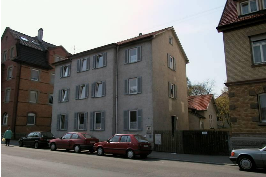
Vorher: Bestand Vorderhaus Uhlandstr. 14
