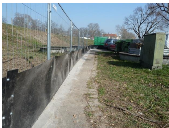
Abbildung 7: Beispielskizze eines Reptilienschutzzaunes (rechtes Bild). Auf dem linken Bild wurde der Zaun in einen Schlitz in der Gehwegdecke eingelassen.
