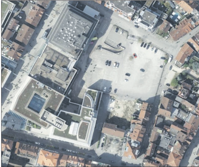
Das Luftbild zeigt das Karstadt-Gebäude samt Parkplatz.
