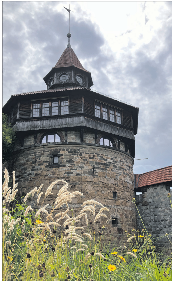
Innerhalb des hölzernen Aufbaus des Dicken Turms befindet sich der Turmsaal, der bis Ende kommenden Jahres saniert werden soll.
