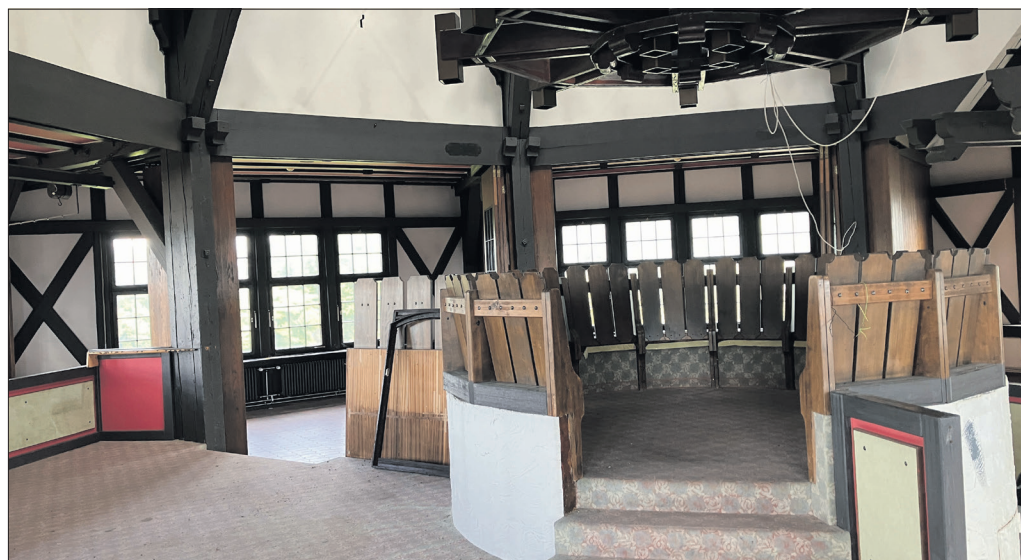
Die Beletage Esslingens wird grundlegend erneuert und fit für die Zukunft gemacht.
