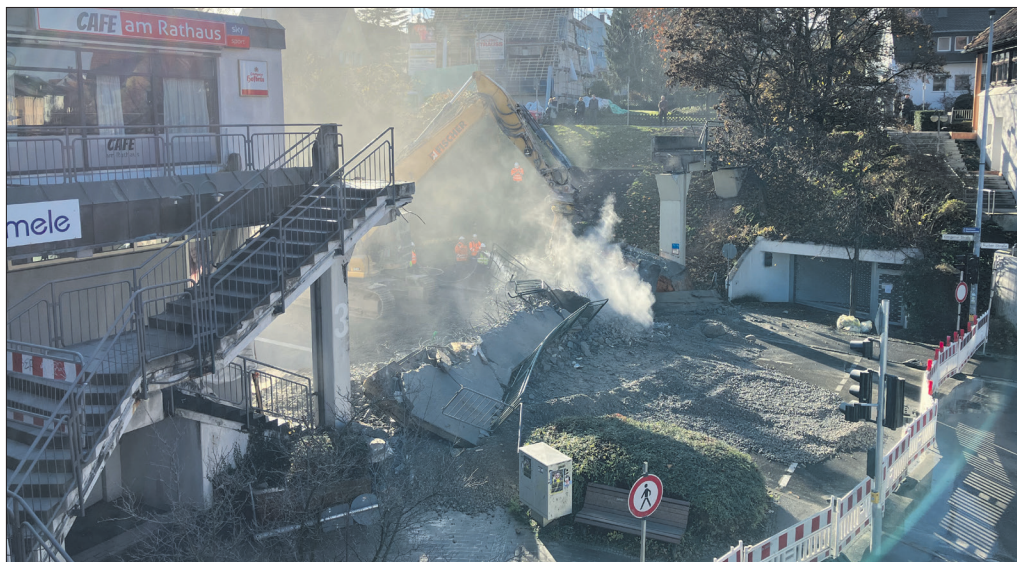
Bis Mittwochmittag war der Fußgängersteg in Berkheim abgebrochen.
