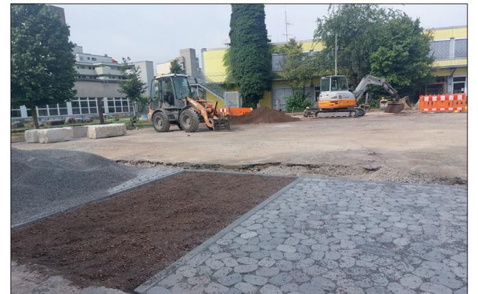
Durch Pflaster und Fugen kann der Regen in das Baumbeet sickern, das sich unterirdisch über die gesamte Breite erstreckt. So haben die Wurzeln viel Platz. Foto: isa
